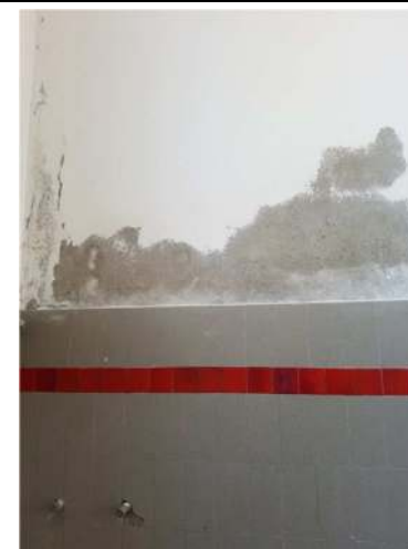
Particolare parete sala uscita merce
