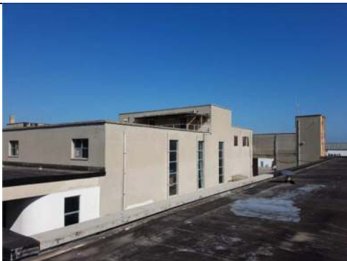
Vista dell'edificio centrale
