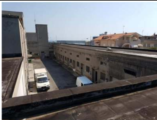
Vista fronte magazzini commercianti
