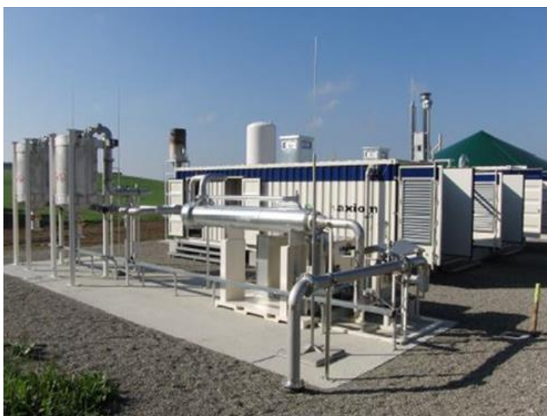
Figura 28 - Esempio di tecnologia di Upgrading mediante membrane
