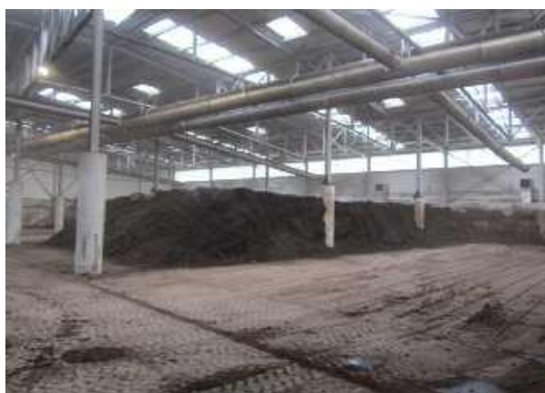
Figura 18 - Cumuli di maturazione del digestato stabilizzato
