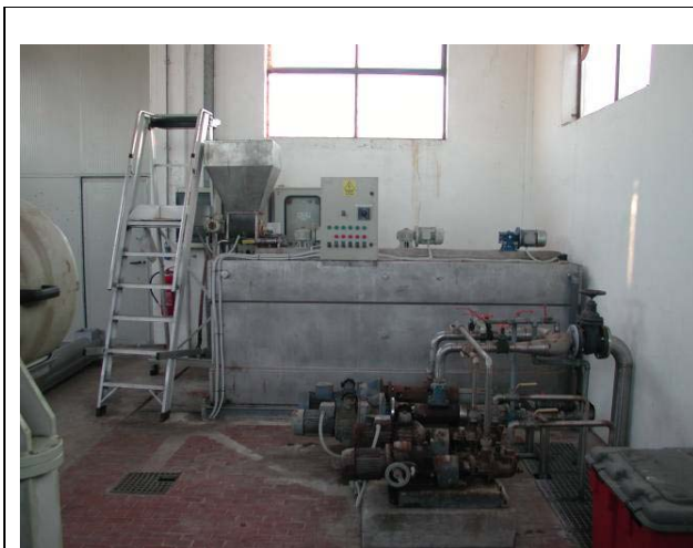
Foto 15– DOSAGGIO DI POLIELETTROLITA
