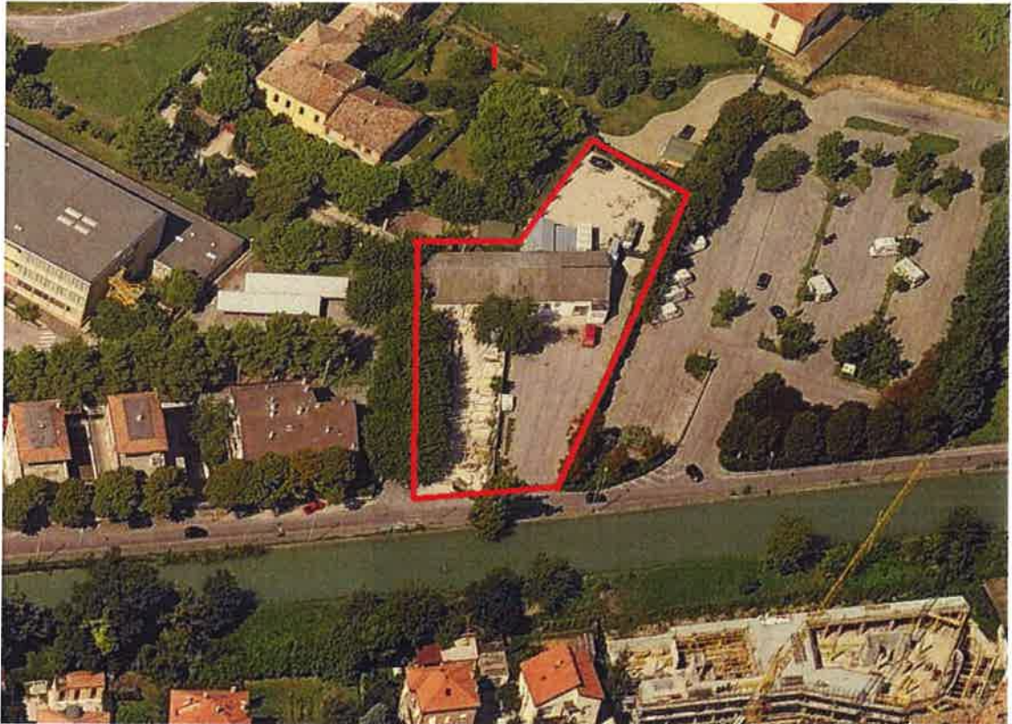
VISTA AREA D'INTERVENTO – FRONTE
