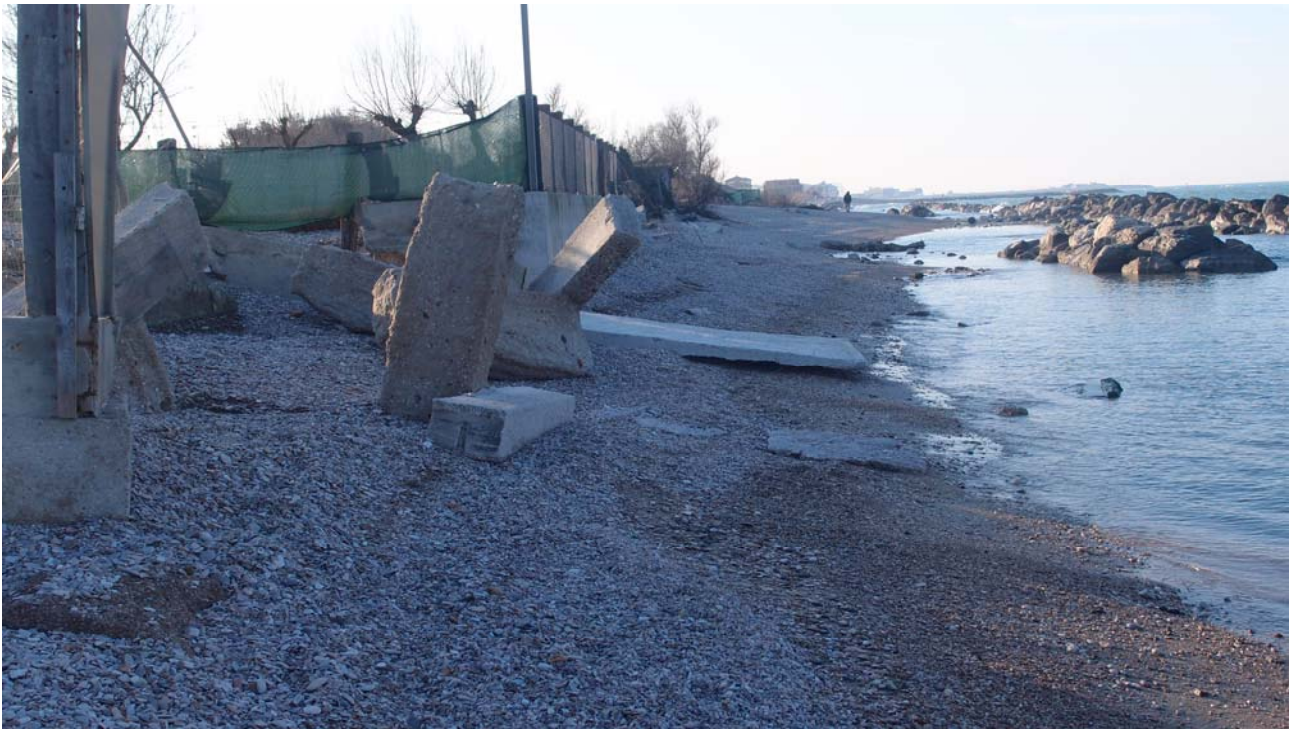
Foto. 4.5/2 – Le scogliere radenti disposte in modo frammentato ed elementi antropici distrutti dalle mareggiate in zone del Bersaglio.
