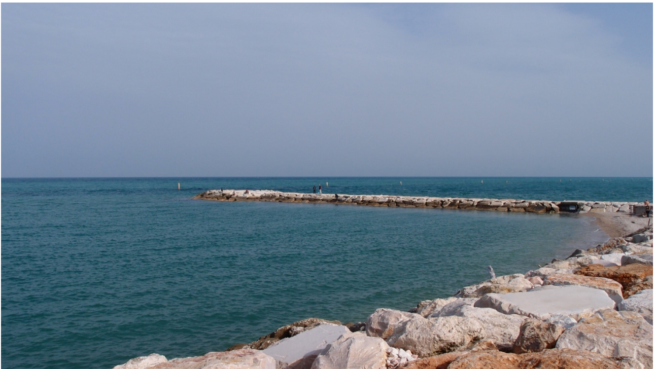
Fig. 3.4/4 - Pennello e massicciata in località Viale Ruggeri.
