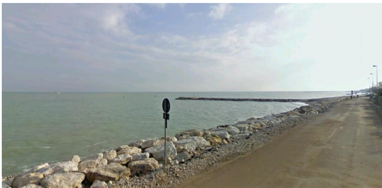
Fig. 1.2/1 - Massicciata a protezione stradale in zona "bersaglio"
