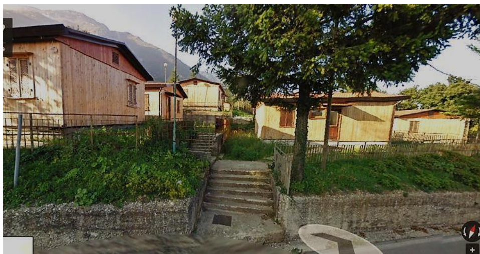
Figura 28 - Esempio di costruzione semipermanente soggetta a numerazione civica. Comune di Senerchia (AV) - Fonte Elaborazione su Google Earth
