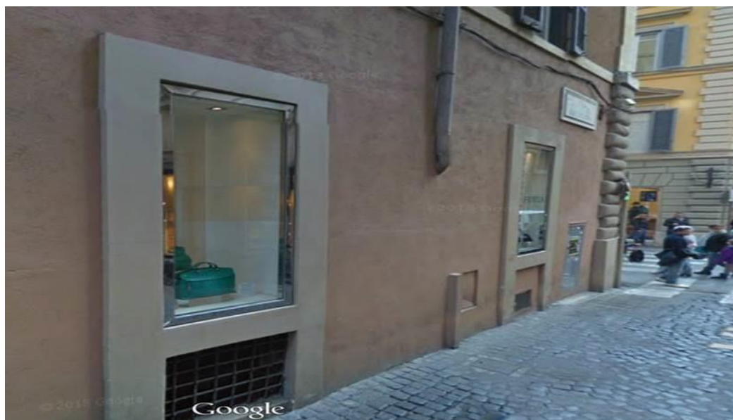
Figura 20 - Esempio di accessi rialzati a più di 25 cm dal livello stradale. Via Belsiana, Comune di Roma - Fonte Elaborazione su Google Earth
