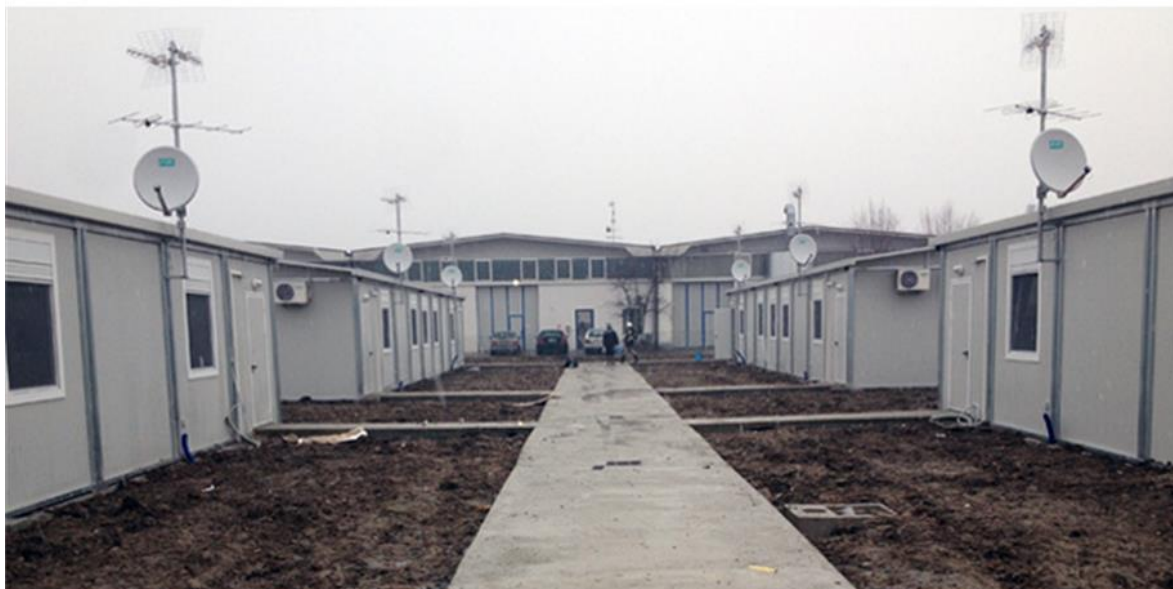
Figura 29 – Esempio di prefabbricati modulari abitativi rimovibili. Novi di Modena e Rovereto di Novi (MO)
