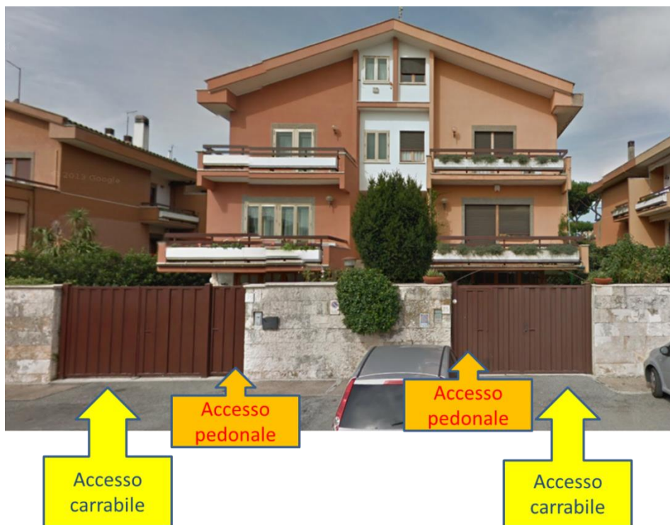
Figura 13 - Esempio di accessi pedonali e carrabili contigui che immettono su un unico livello. Prospetto su Via Genovese Zerbi, Comune di Roma - Fonte Elaborazione su Google Earth
