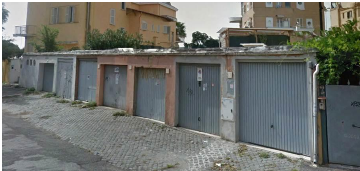
Figura 17 – Esempio di numerazione civica ai singoli box con accesso diretto su strada. Via Bocche di Bonifacio, Comune di Roma - Fonte Elaborazione su Google Earth
