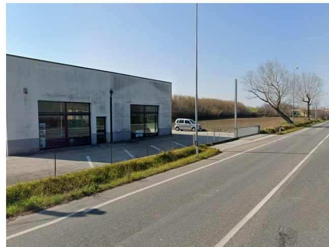
Attività commerciale lungo la Strada Statale Adriatica
