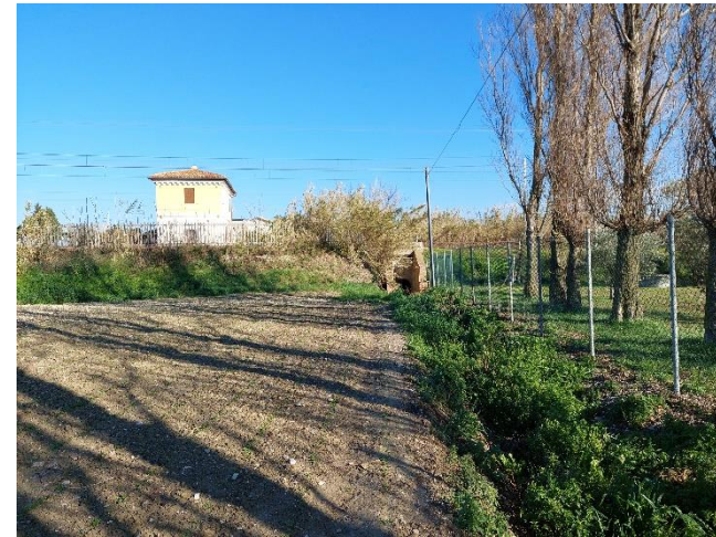
Vista in corrispondenza del sottopasso idraulico esistente
