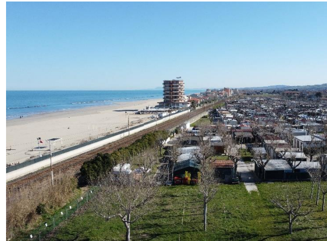
Vista del punto di attraversamento della ferrovia
