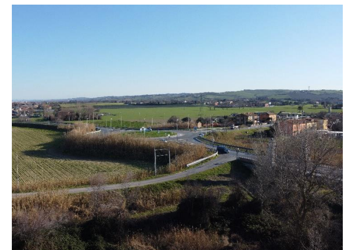
Vista complessiva della rotonda e dell'attacco al ponte
