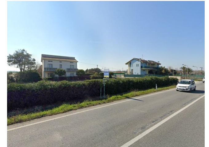
Tratto di Strada Statale con fosso di guardia e giardini privati
