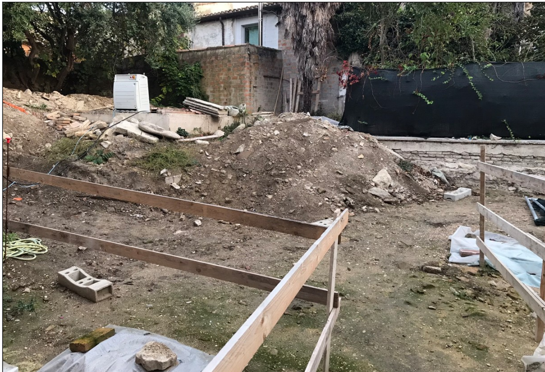
Fig. 8 Vista generale dell'area di scavo
