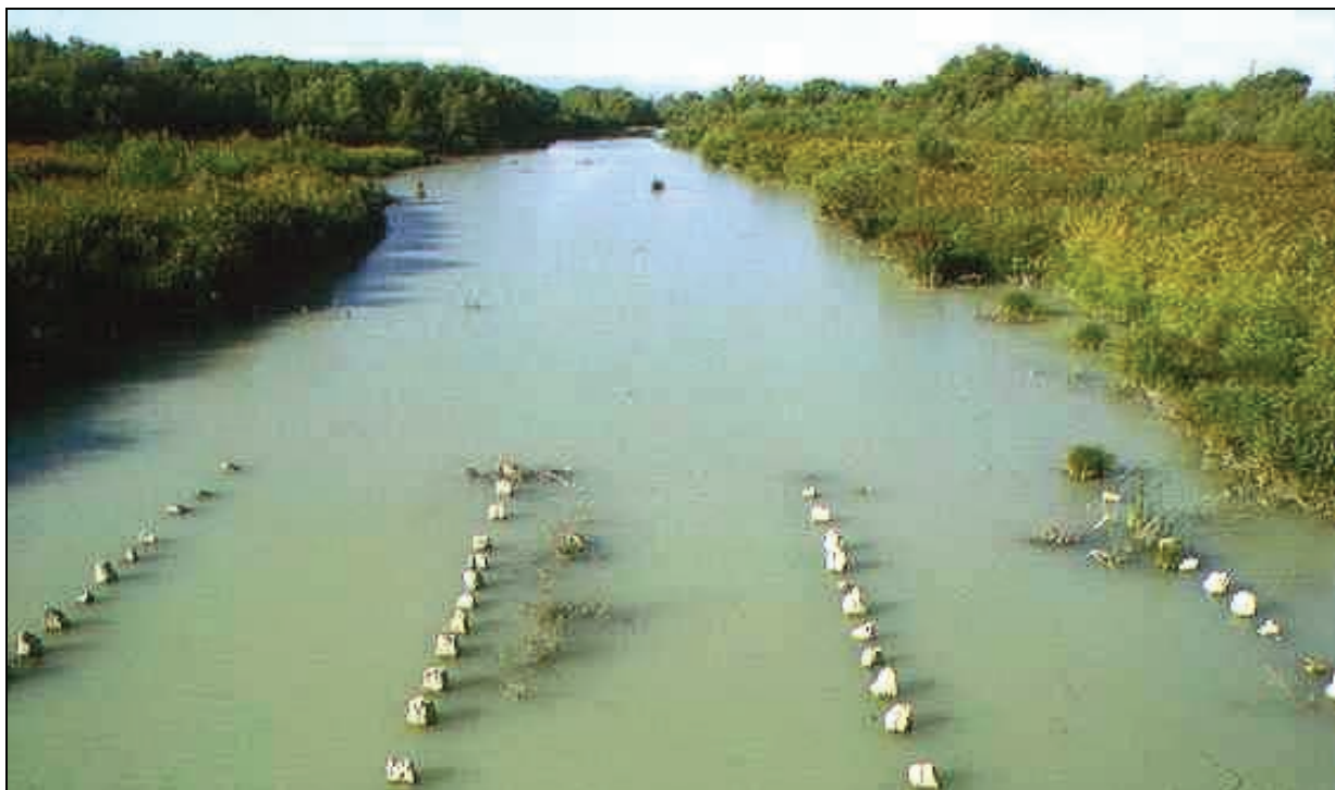
1a.2 Resti del ponte in legno a fianco dell'attraversamento attuale della S.S. n.16.
