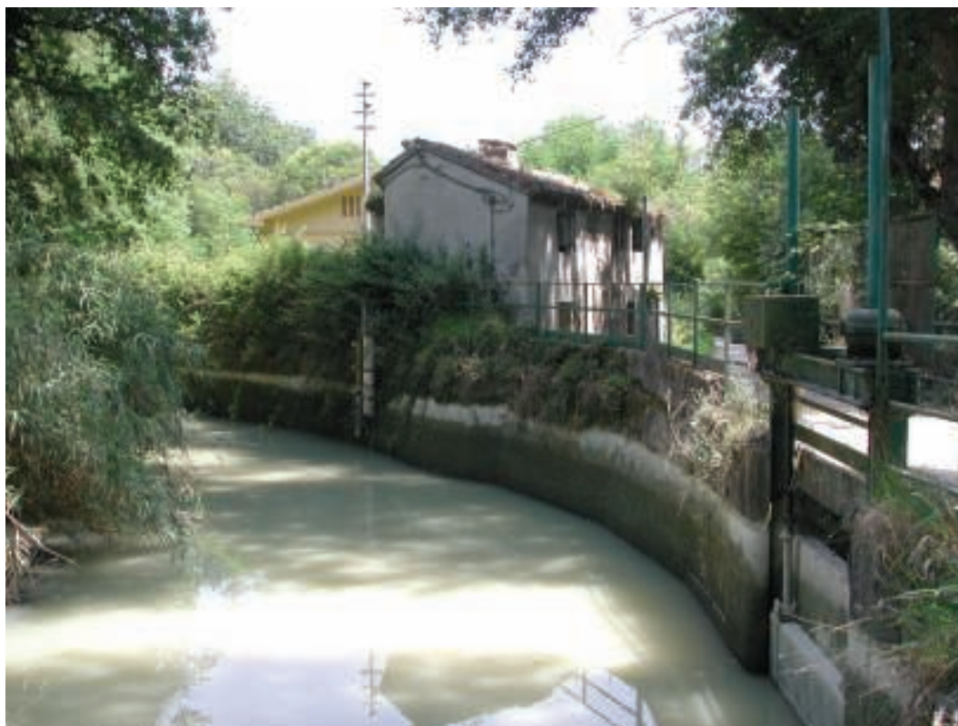
2.5 Edificio denominato "Chiusarolo", presso le portelle.
