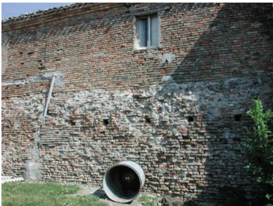
3.2 Resti di muratura dell'antico fortilizio, sul retro dell'edificio .
