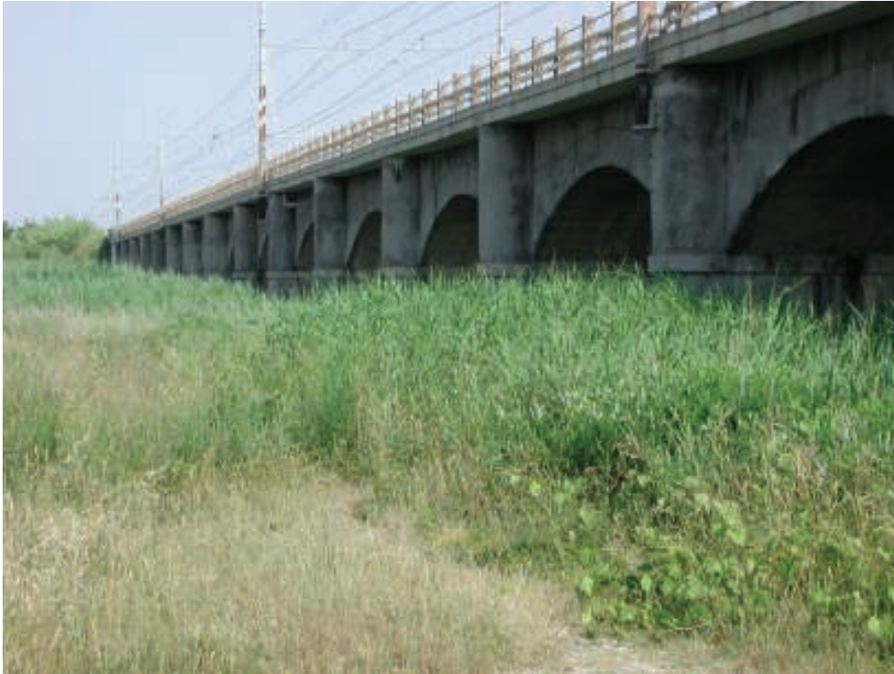
1a.4 Il ponte della ferrovia Bologna-Bari presso la foce del fiume.
