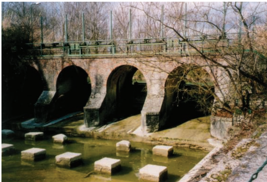
2.4 Portelle per la regolazione delle acque del Canale.
