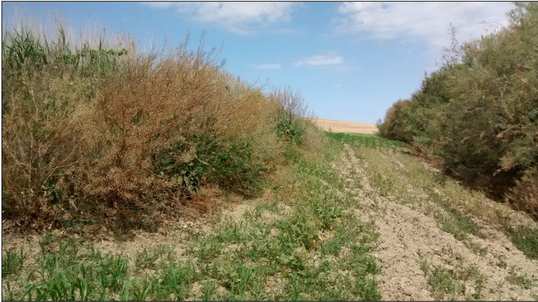
Fotografia della diga del laghetto (26/05/2020)
