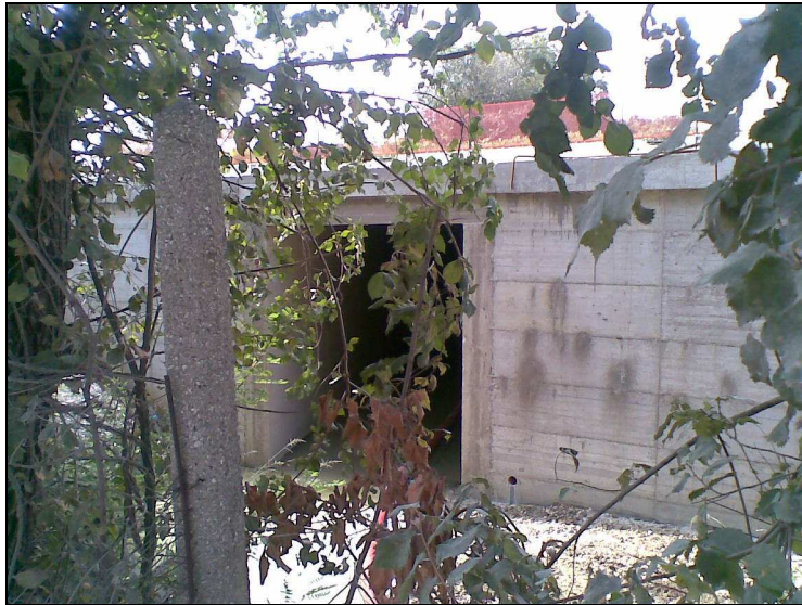
Scatolare di attraversamento autostrada
