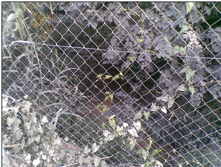
Fosso a valle dell'autostrada
