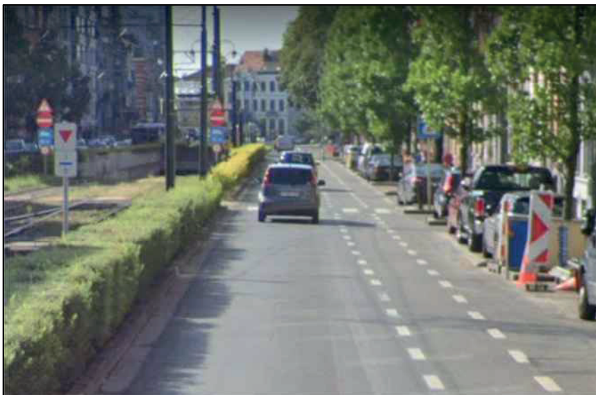
Il franco rispetto alla sosta è ampliato riducendo l'ampiezza della corsia ciclabile (Bruxelles).
